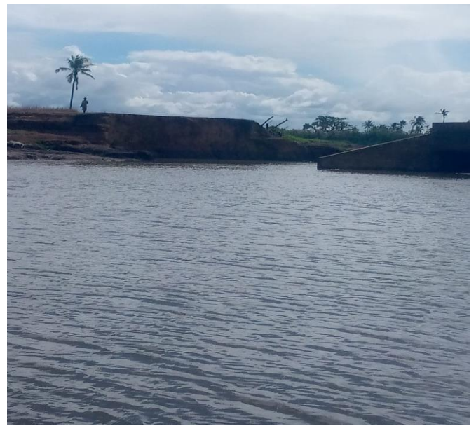
自然災害で破壊された防護堤 (Edson Marina)
