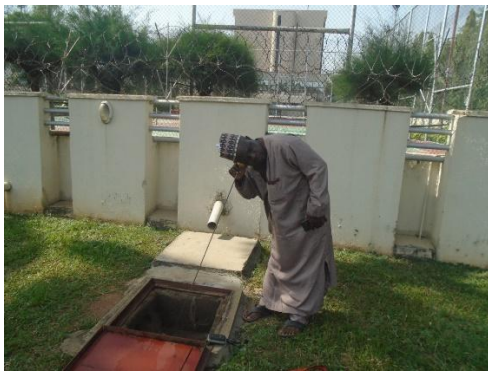
1. 漏水探知機を使う FCTWB 職員
