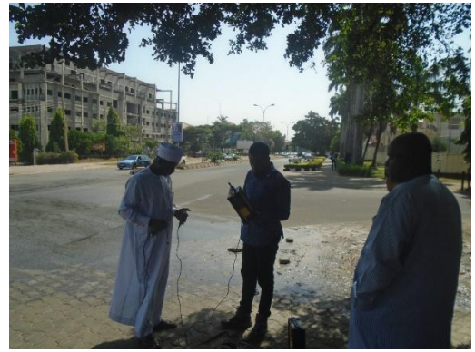
2. 漏水探知機の較正作業中
