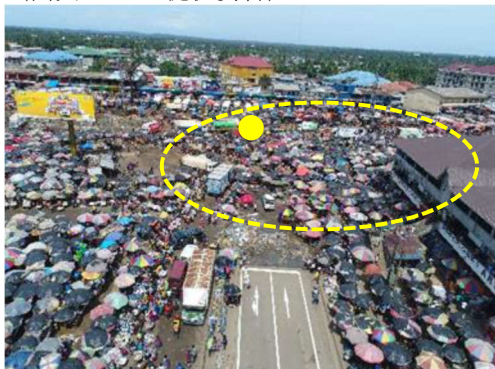
写真5 第二次完工時（2021年7月）13.175km地点、レッドライト交差点整備前（出典：JICA提供資料）
