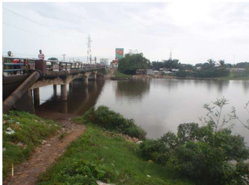
写真3 着工前ストックトン橋（2013年2月）（出典：JICA提供資料）
