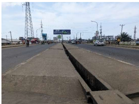
写真 11 きれいに維持管理された工業地帯の中央分離帯の排水溝（出典：評価者）
