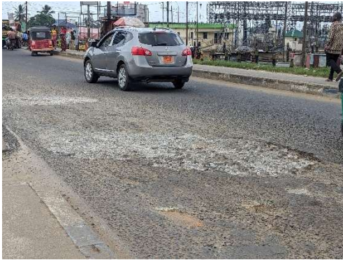
写真13 第一次道路 Jamaica Road 交差点手前のポットホール（2024年11月）（出典：評価者）
