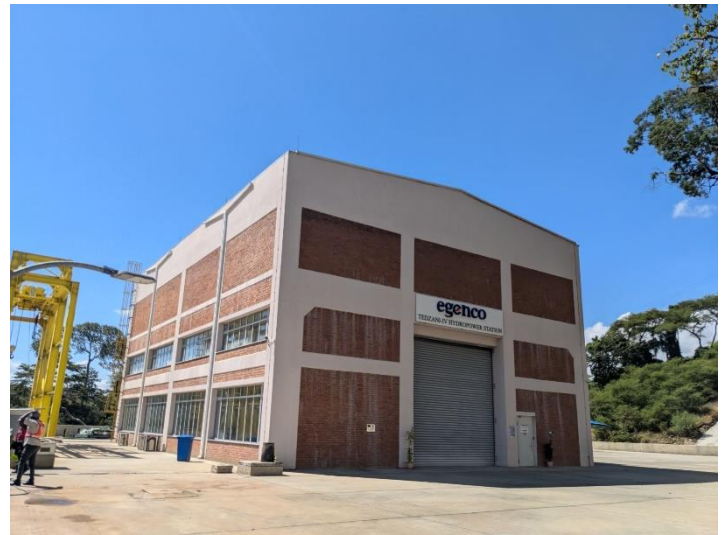
写真2 テザニ水力発電所 IV 号機建屋 (出典：外部評価者撮影)
