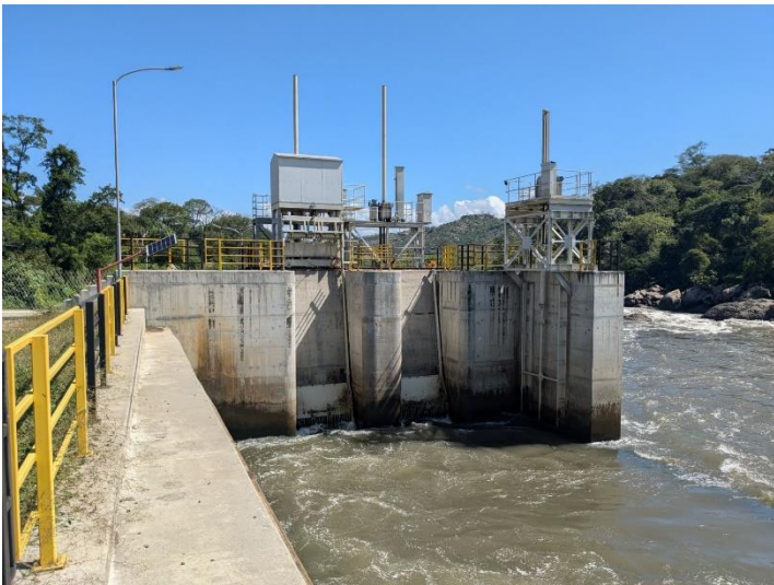
写真1 テザニ水力発電所 IV 号機用取水口 (出典：外部評価者撮影)
