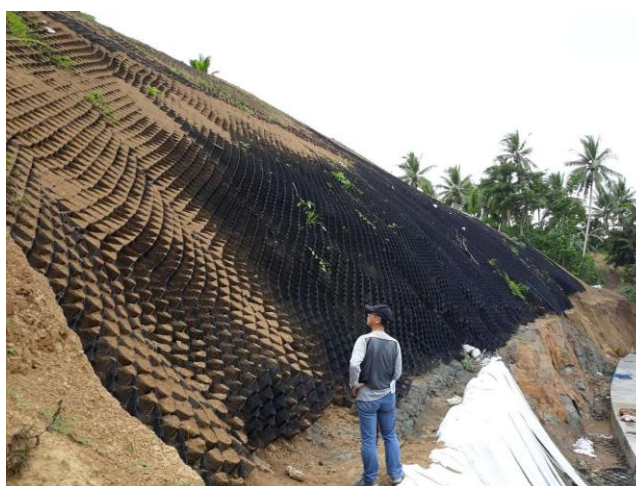
アルバイ西海岸道路 アルバイ州、2018年 (道路斜面保護工事)
