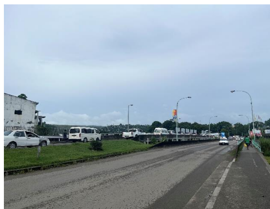
写真2 拡幅した新マタニコ橋（奥側が拡幅した2車線）（出典：外部評価者撮影）
