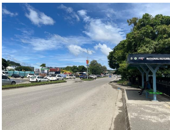
写真1 改修したクム幹線道路及び設置したバスベイ（出典：外部評価者撮影）
