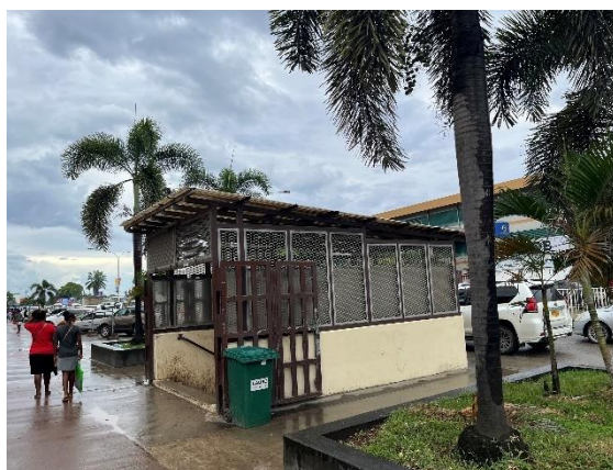
写真9 改修の上再利用されている 横断地下道① (出典：外部評価者撮影)
