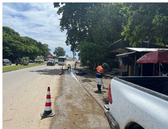
写真8 側溝の詰まりを掃除する MID の委託業者 (出典：外部評価者撮影)
