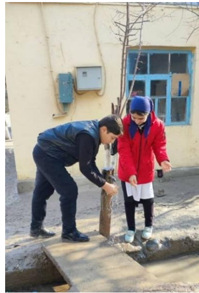
写真2 学校に設置された蛇口 (現地調査補助員撮影)
