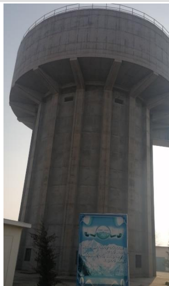
本事業で設置した高架水槽 （出典：現地調査補助員撮影）
