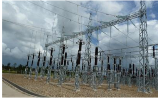
ヒンヘルブ地区における 230/115kV 変電所
