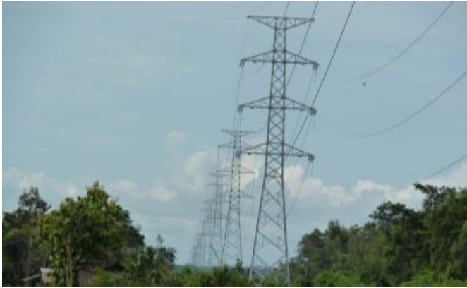
ヒンヘルブ変電所からナサイトン変電所への 230kV 送電線
