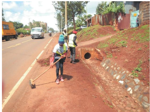
女性労働者による側溝の清掃（JICA 専門家撮影）
