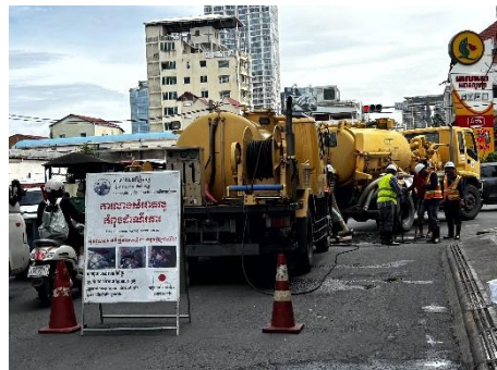
写真 2 看板を出して清掃作業を行う DSO 職員（評価者撮影）
