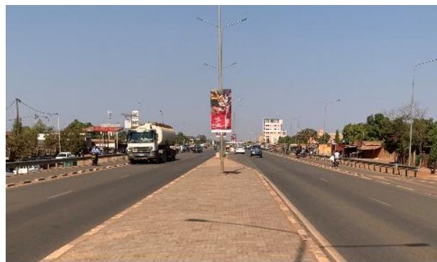
整備されたタンソババイパス道路（出典：評価者撮影）
