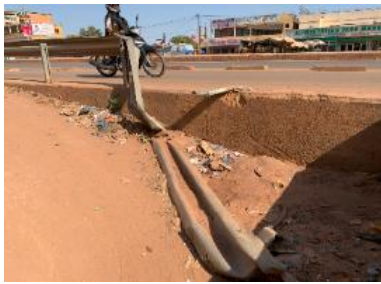
写真 5：倒壊したガードレール 写真 6：タイルが破損している歩道橋 写真 7：破損しているバス停 出典：評価者撮影（写真 5、6、7）
