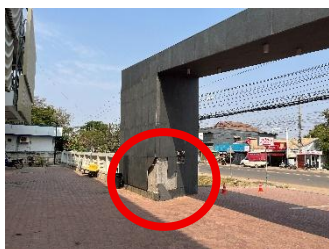
写真 10 セタティラート病院救急入口 (利用者の車の接触によって破損したままになっている)
