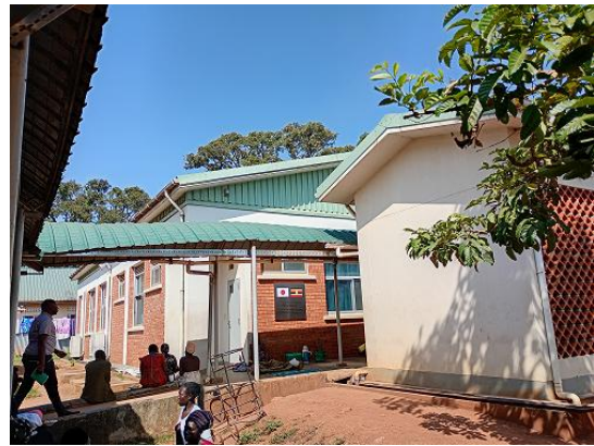
写真5 リラ RRH に整備された分娩棟。 手前は発電機室（出典：評価者撮影）
