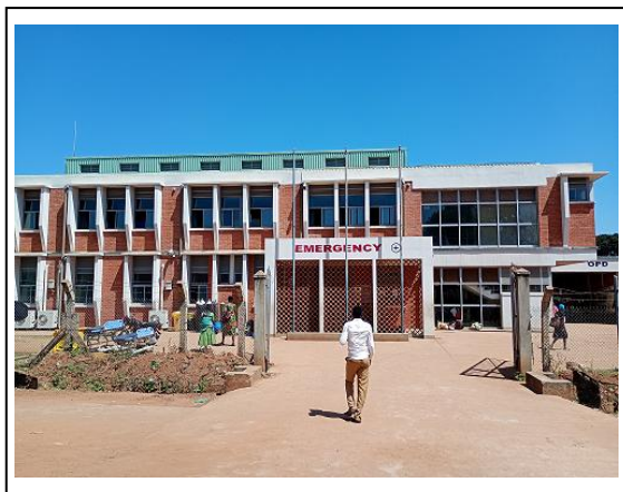
写真1 本事業でリラ RRH に建設された外来・救急外来複合棟 (出典：評価者撮影)
