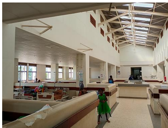
写真4 本事業で整備されたグル RRH の産科病棟 (出典：評価者撮影)
