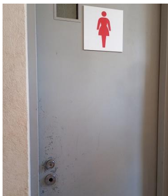
写真 6 ドアノブが紛失しているグル RRH の患者用トイレ（出典：評価者撮影）
