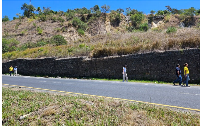
パイロット・プロジェクト (国道 38 号線沿いの地すべり対策 サンサルバドル県デルガド市) (出所：評価者撮影)
