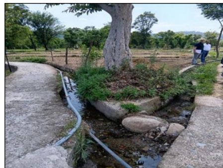
写真 2: カングラ県の自然流下 (重力式) 灌漑地区の灌漑用水路 (出所: 評価者撮影)
