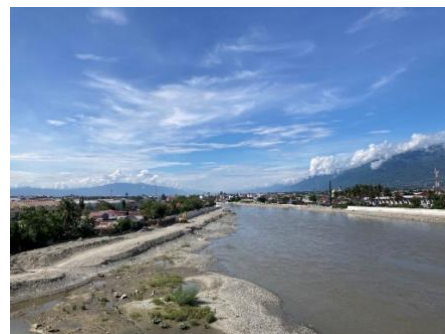
写真 6：パル市のパル川護岸工事 (出典：評価者撮影)
