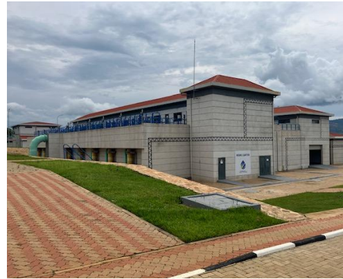
融資先の水供給 PPP サブプロジェクト 浄水処理施設 (出所：評価者撮影)
