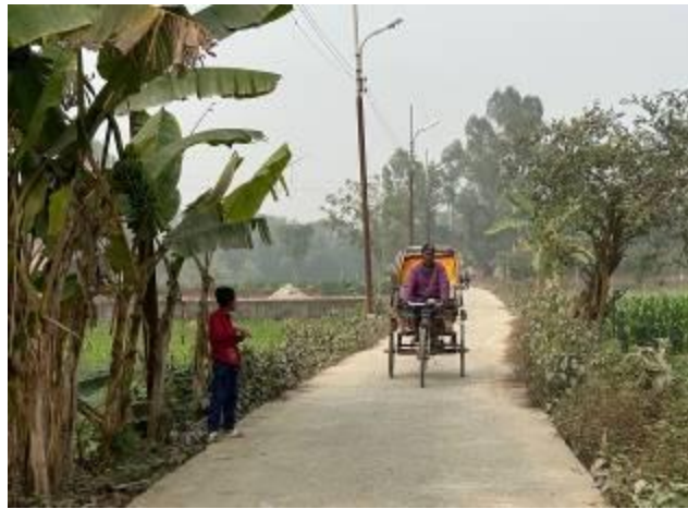
写真 1：本事業で整備した地方都市道路および街灯 (ロングプール県) (出典：評価者撮影)
