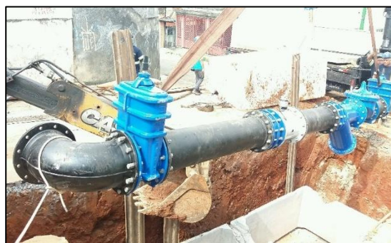
減圧弁の設置
