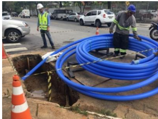
写真2：配水管の更新（出典：SABESP 提供）
