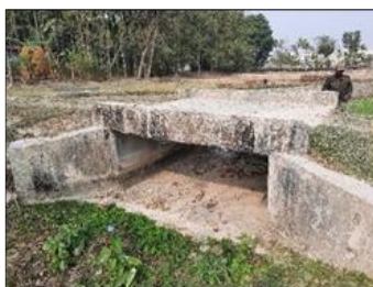
写真7 暗渠 (ボックス・カルバート)
