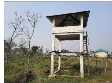
写真5 監視塔 (出典：評価者撮影)
