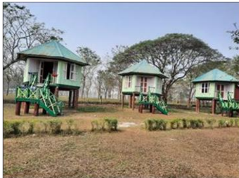
写真 12 EDC によるエコツーリズム事業 (1) (ジャルパイグリ県)
