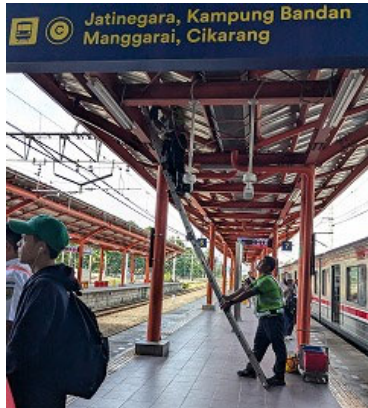
写真 1：ホーム屋根のメンテナンス
