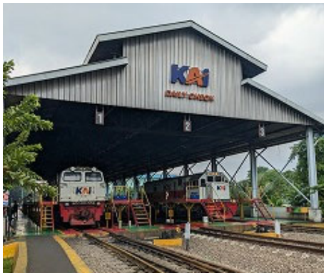
写真 3：本事業で建設した チピナン車両基地（日常点検場）
