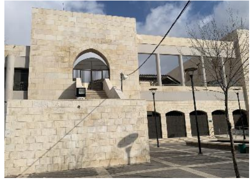
プログラム No.6 のサイトの1つ（アンマンラガダンバスターミナル）－石壁の修繕（出典：評価者撮影）
