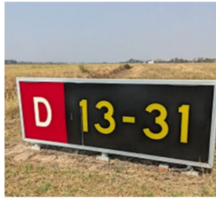
誘導路の案内板 (LED システム故障により夜間点灯しない)
