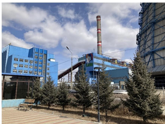
写真 5：第 4 火力発電所の全景 （出典：評価者撮影）
