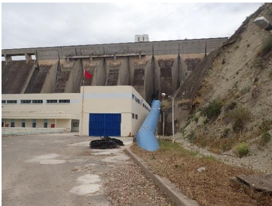
写真1 イドリス一世ダムと取水管の様子 (出典：評価者撮影)
