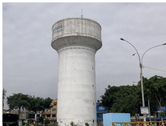
修復された配水池 1
