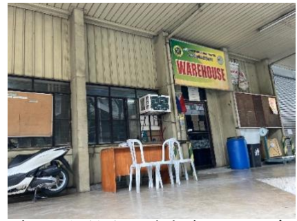
写真2：保健省地域事務所 IV-A 倉庫 (出典：評価者撮影)
