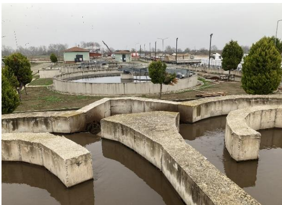
写真 3：整備された下水処理施設 (チャナッカレ県ビガ) (出典：評価者撮影)
