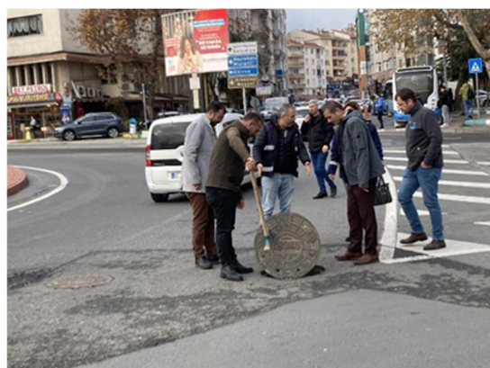
写真 7：下水マンホール （テキルダール県テキルダール西地区） （出典：評価者撮影）
