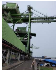
写真 3：石炭運搬用設備を含む港湾 (出典：評価者撮影)
