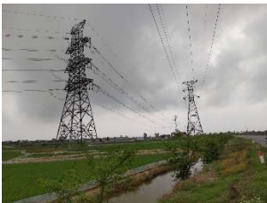
写真 5：タイビン火力発電センター～タイビン変電所区間の送電線 （出典：評価者撮影）
