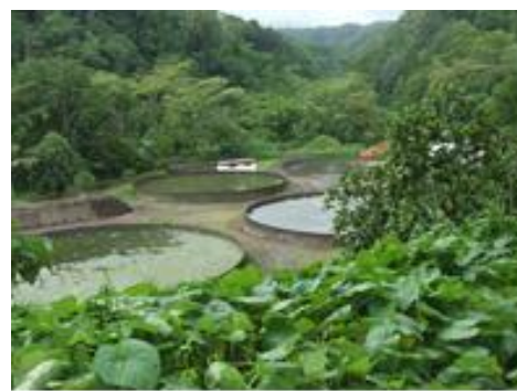
清流時の浄水場ろ過池
