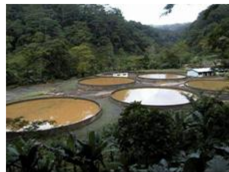
濁水流入時の浄水場ろ過池
