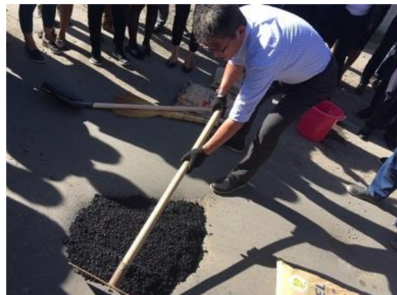
提案製品を活用した道路補修の様子
