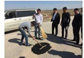
補修箇所ポットホールへの敷均
