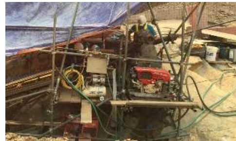
ダムサイトの地盤調査(斜掘り)
