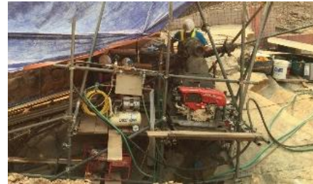
ダムサイトの地盤調査(斜掘り)
