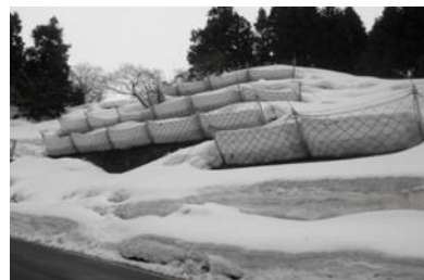
雪崩予防柵（ARC Fence Snow Type）（日本）
