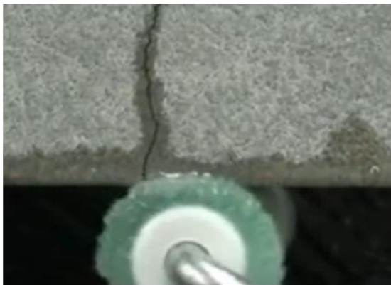
天井面ひび割れにも浸透 (エポキシ樹脂補修材)
