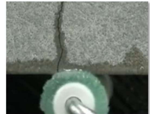
塗布するだけで天井面ひび割れに浸透
