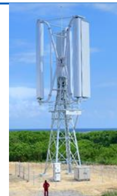
10kW垂直軸型マグナス型風力発電機
