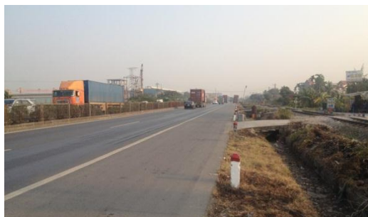
設置予定場所。多くの大型トラックが往来している。
