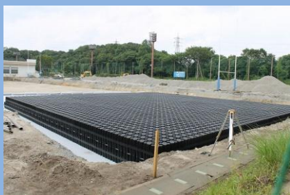
プラスチック製雨水貯留槽 プラダムくん
