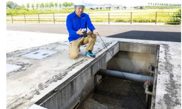
集落排水システム
