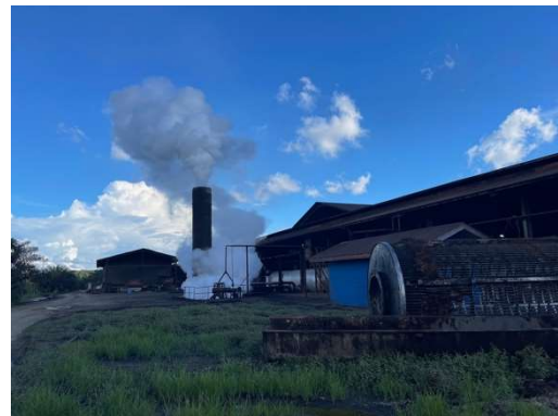
搾油工程で発生す流廃蒸気
