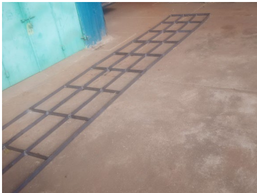
現地で製造したマット苗用の鉄枠
