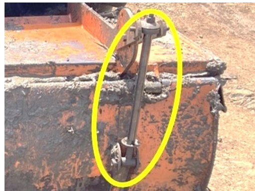
スプリングを鉄パイプへ交換して固定
