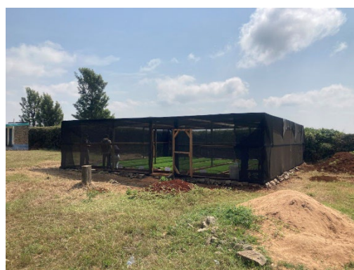
遮光率 75%のネットで覆われている育苗施設 (病害発生)
