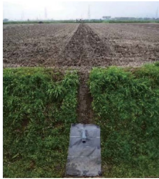
暗渠管末端 出典：農研機構 トラクタで利用できる 浅層暗渠施工器
