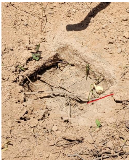
写真 18 木の根が密集した地面の掘削後の様子
