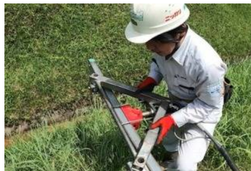
写真：現地レール施工状況
