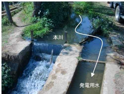
図 15 農業水路と発電用水路の分水地点
