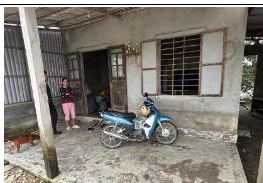
写真 11 Phú Vang 地区の浸水エリア
