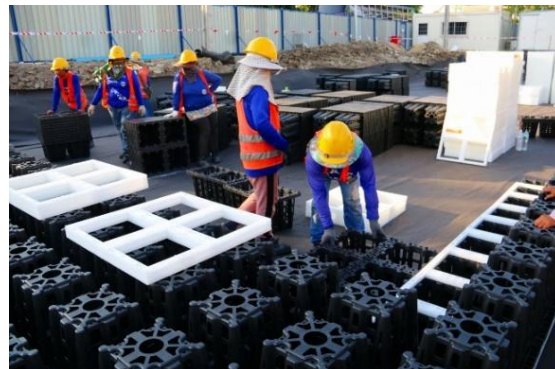
図 I.31 ニュープラくん組立図と施工の様子
