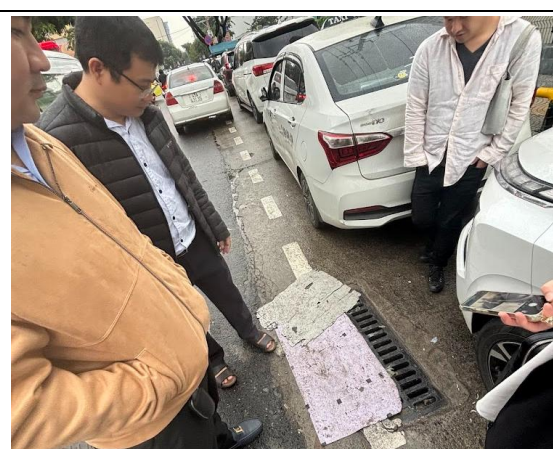
写真 15 Hải Châu 地区の病院前 (排水グレーチングに布蓋がされている)
