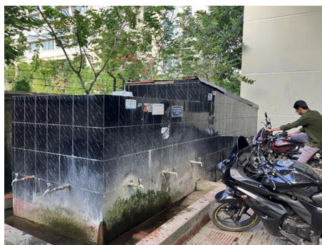
図 3.2.2 DPHE が設置した AIRP
