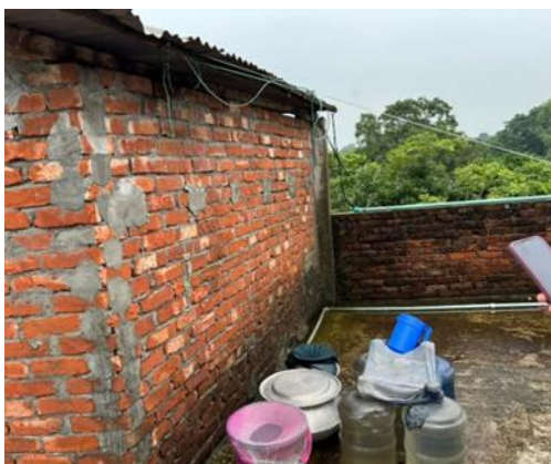
図 4.2.6 雨水の収集状況
