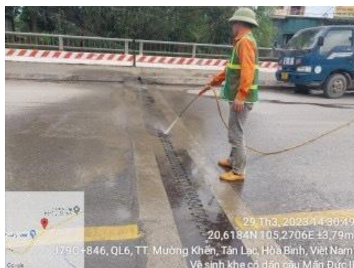
図9 鋼製ジョイントの日常清掃の写真
