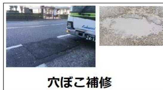
図 19 ポットホール補修の適用事例
