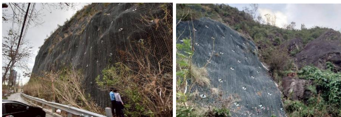
図 I-11 グエン・ダット・タン通り Maccaferri 社の覆い式金網
