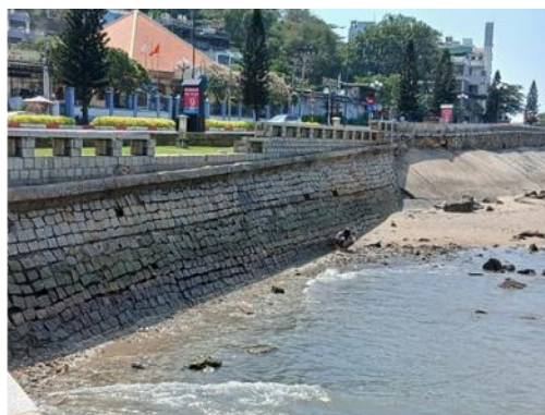
図 I-15 フロントビーチ対策護岸状況
