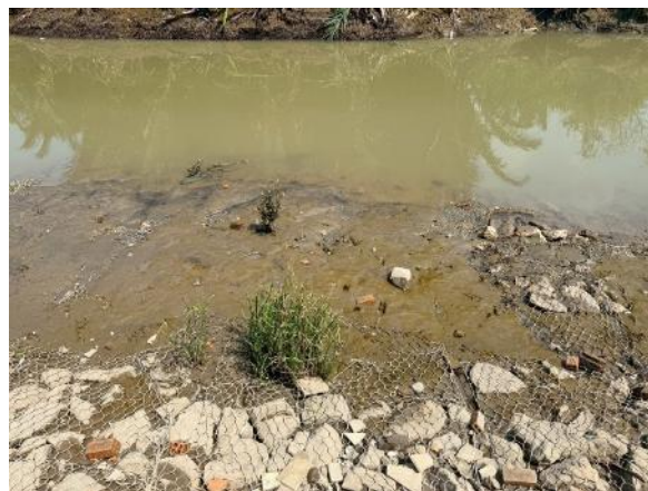
図 I-14 河岸沿いの石かご護岸工状況
