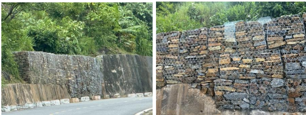
図 I-9 ダナン市ハイバン峠道の斜面对策工現場
