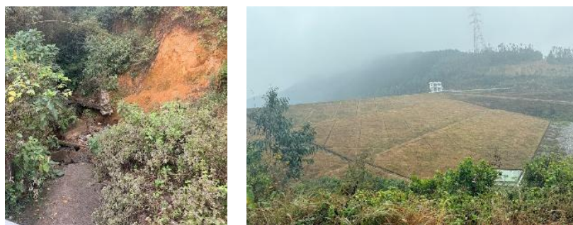
図 I-4 ホ・パップ・カイ湖洪水放流口斜面被災状況およびダム施設法面
