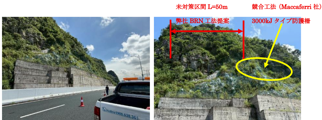
図 I-5 クアンニン省ハイフォンーモンカイ高速道路 KM44 地点落石被災現場
