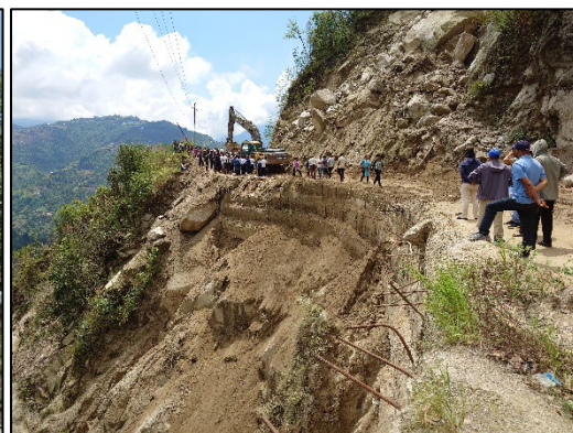
図 2-3 災害復旧作業例
